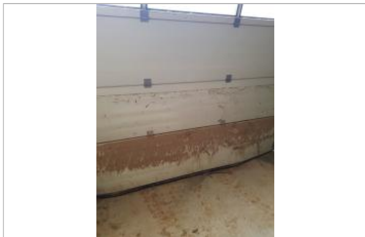
Porte de garage (côté intérieur), habitation rue de Pointvillers
