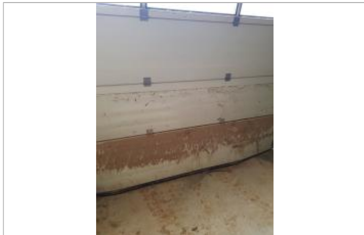
Porte de garage (intérieur), habitation rue de Pointvillers
