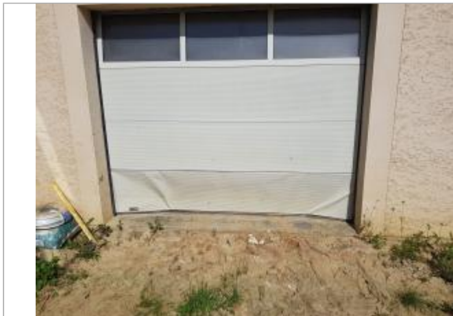
Porte de garage, habitation rue de Pointvillers
