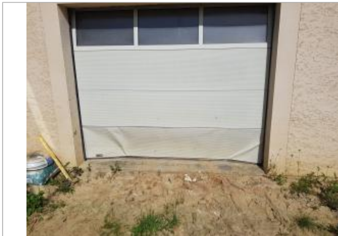
Porte de garage, habitation rue de Pointvillers
