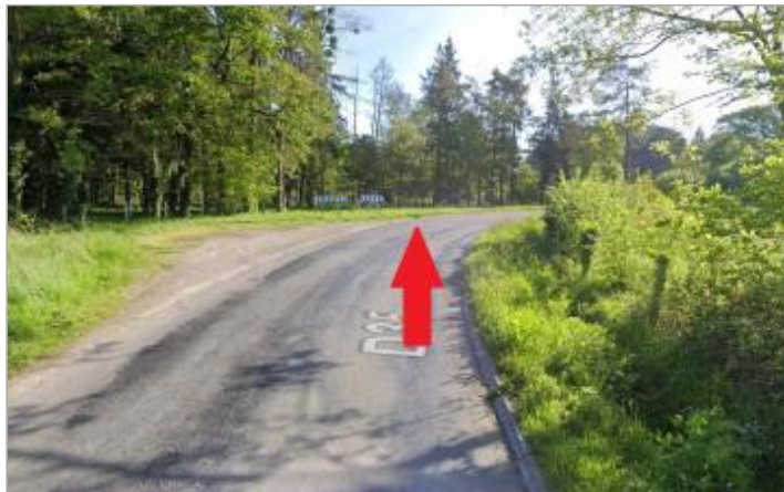
Chaussée de la RD 35 au lieu-dit Branval dans le virage
