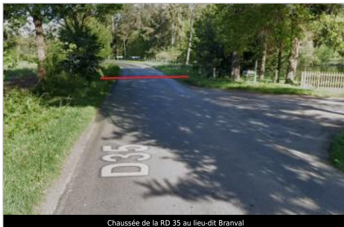
Chaussée de la RD 35 au lieu-dit Branval
