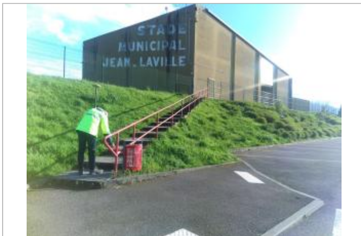
Vue du site en 2024 avec le repère de la crue d'avril 2024
