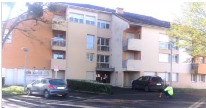
Vue du site en 2024 avec le repère de la crue d'avril 2024
