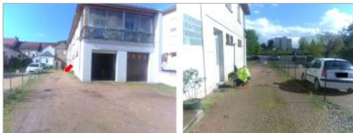
Vues du site en 2024 avec le repère de la crue d'avril 2024
