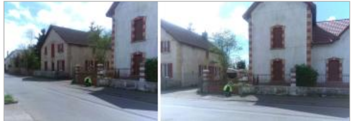
Vue du site en 2024 avec le repère de la crue d'avril 2024
