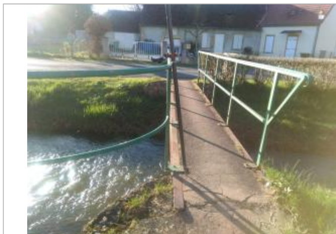
Vue du repère en 2024
