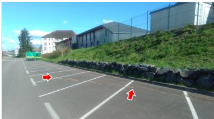
Vue du site en 2024 avec la laisse de la crue de mars 2024
