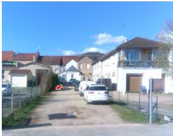
Vue du site en 2024 avec la laisse de la crue de mars 2024
