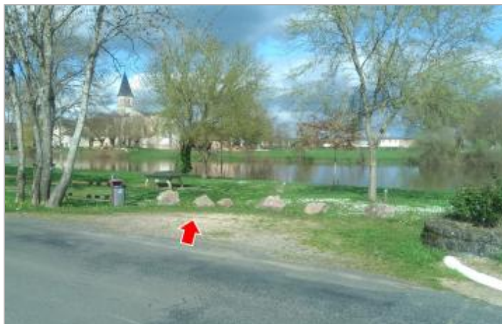
Vue du site en 2024 avec la laisse de la crue de mars 2024
