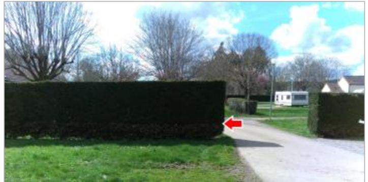
Vue du site en 2024 avec la laisse de la crue de mars 2024
