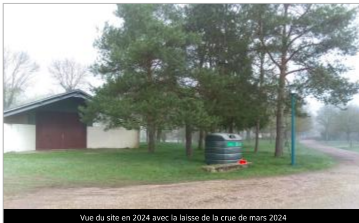
Vue du site en 2024 avec la laisse de la crue de mars 2024
