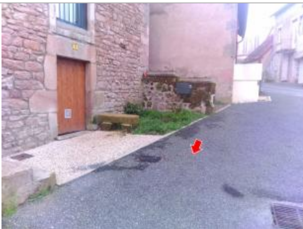
Vue rapprochée du repère en 2024
