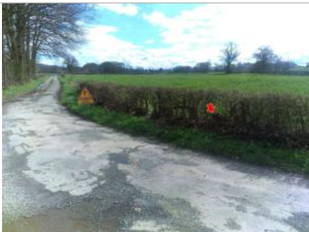
Vue du site et du repère en 2024
