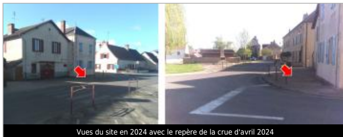
Vues du site en 2024 avec le repère de la crue d'avril 2024
