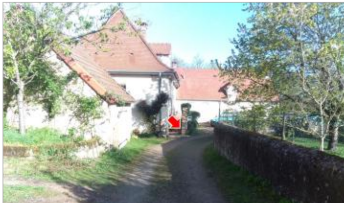
Vue du site en 2024 avec le repère de la crue d'avril 2024
