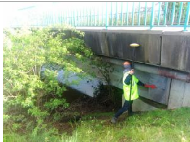
Vue du site en 2024 avec le repère de la crue d'avril 2024
