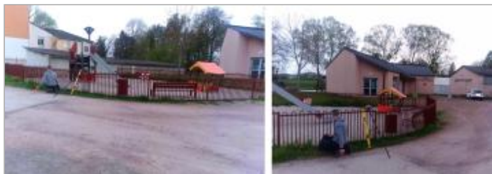
Vues du site en 2024 avec le repère de la crue d'avril 2024
