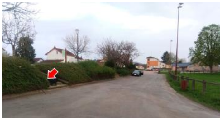
Vue du site en 2024 avec le repère de la crue d'avril 2024
