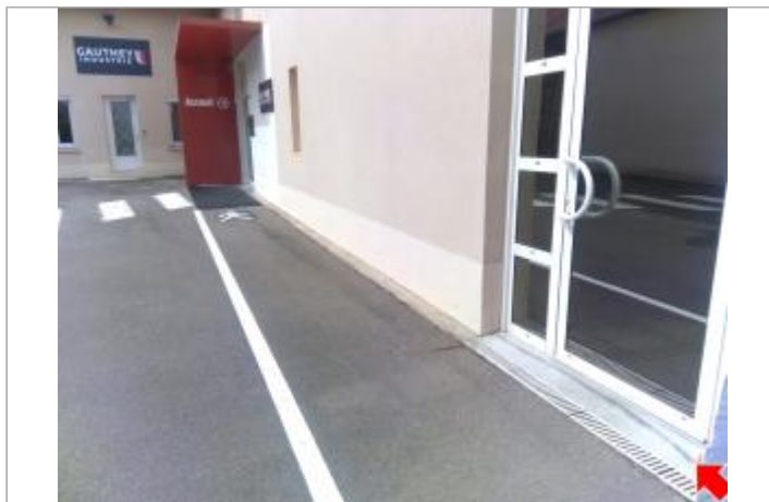
Vue du site en 2024 avec le repère de la crue d'avril 2024
