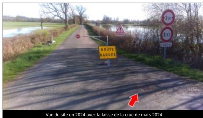
Vue du site en 2024 avec la laisse de la crue de mars 2024
