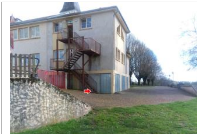
Vue du site en 2024 avec la laisse de la crue de mars 2024
