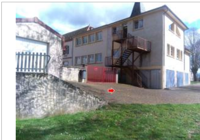
Vue du site en 2024 avec la laisse de la crue de mars 2024
