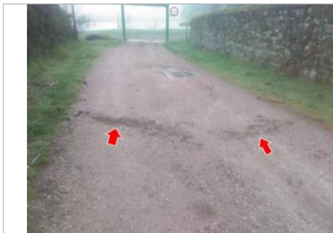
Vue du repère en 2024
