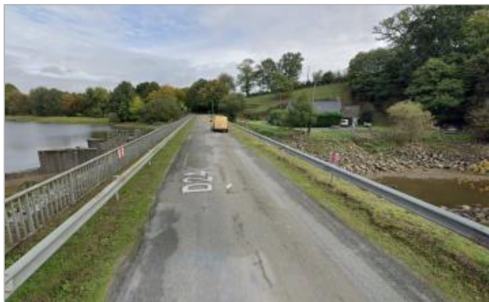
Pont de la RD 24 à Saint-M'Hervé
