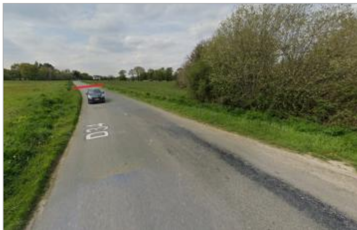
Chaussée de la RD34 à Mordelles
