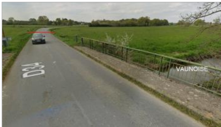
Chaussée de la RD34 à Mordelles
