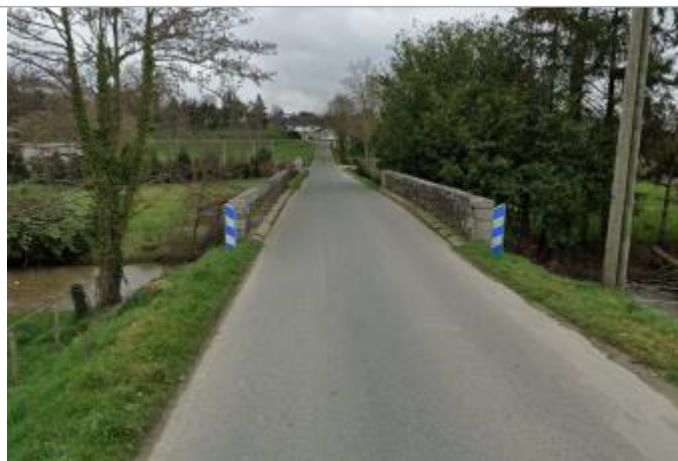
Pont de la RC4 à Poce-les-Bois
