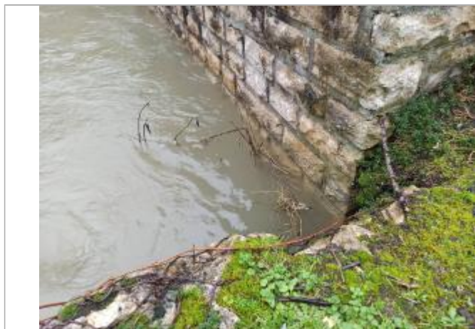
En amont du pont RD 437, 3 rangées de pierres sous le niveau du gabion (branche en référence au niveau du gabion).
