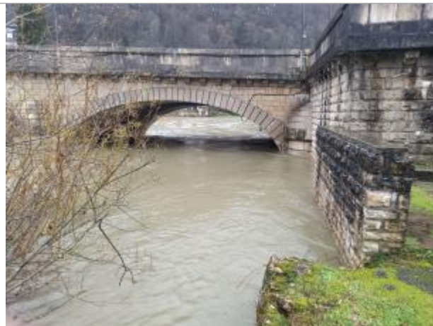
mur amont du pont de la RD437 (rive droite)
