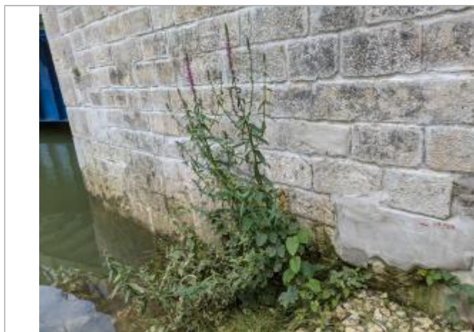
Marque de peinture sur la pile amont du pont rive droite
