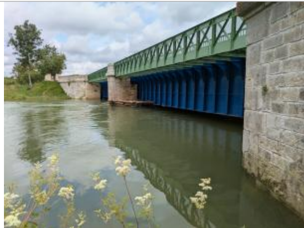
Pont-canal de Rouvroy-sur-Marne
