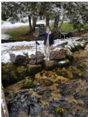
Amont du pont en rive droite, au milieu de la pierre plate et inclinée
