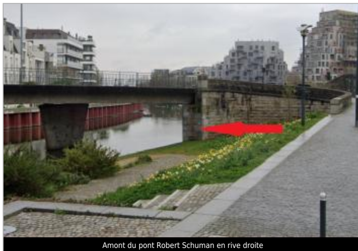
Amont du pont Robert Schuman en rive droite
