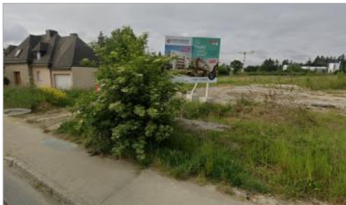
Nouveau quartier rue des folies en cours d'aménagement
