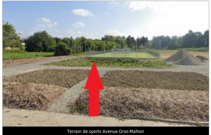
Terrain de sports Avenue Gros-Malhon
