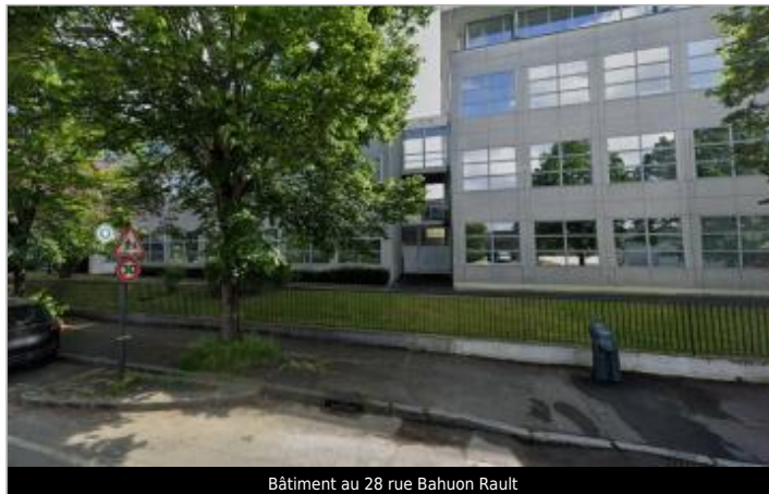
Bâtiment au 28 rue Bahuon Rault
