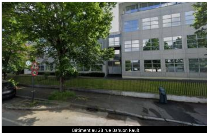
Bâtiment au 28 rue Bahuon Rault
