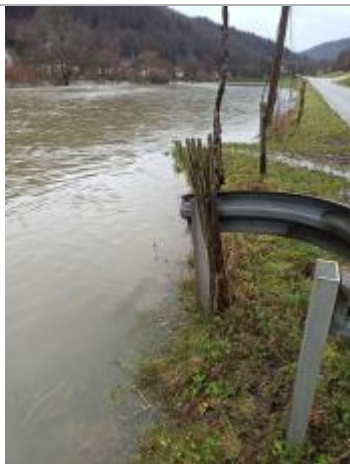
Entrée commune (Doubs amont). En amont du pont en rive gauche. Au pied de l'extrémité de la glissière de sécurité (démontée depuis)..
