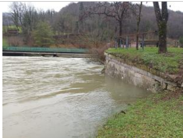
Aval pont rive gauche, mur sous la table pique-nique
