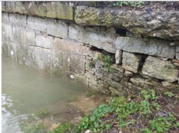
Aval du pont en rive gauche, mur situé sous la table pique-nique
