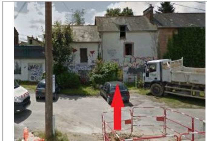
Seconde maison au 72 canal Saint-Martin en juin 2016 avant sa démolition
