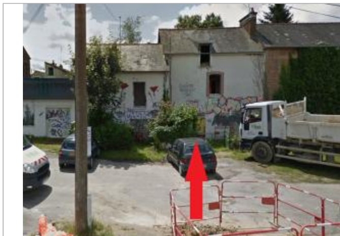
Seconde maison au 72 canal Saint-Martin en juin 2016 avant sa démolition
