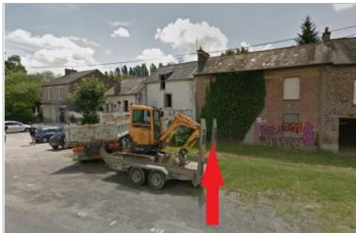
Première maison au 72 canal Saint-Martin en juin 2016 avant sa démolition
