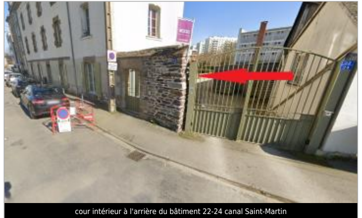
cour intérieur à l'arrière du bâtiment 22-24 canal Saint-Martin
