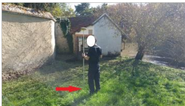
Laisse de crue au sol.
