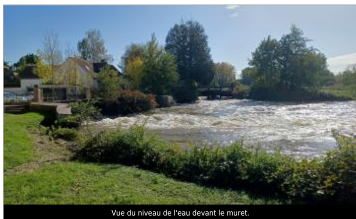
Vue du niveau de l'eau devant le muret.
