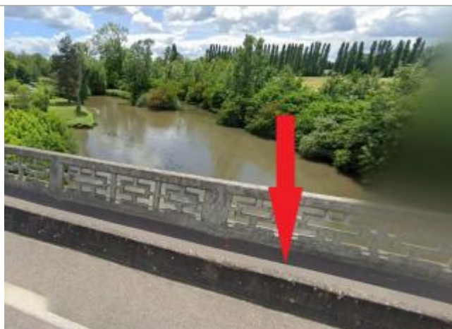
Nivellement du tablier du pont
