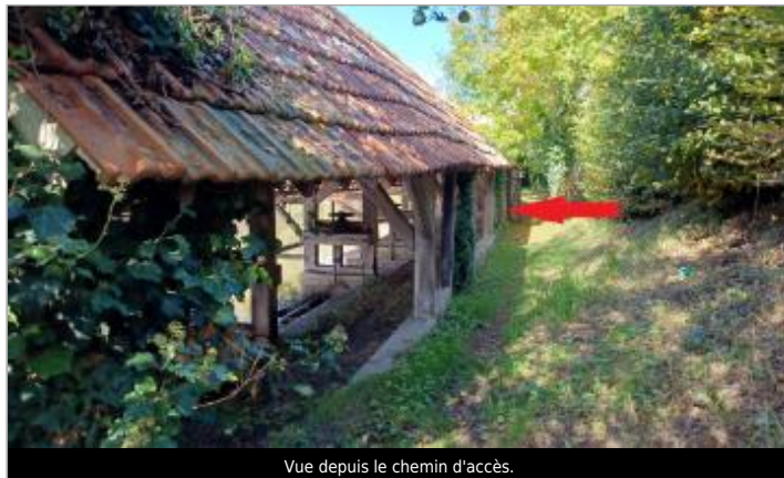
Vue depuis le chemin d'accès.
